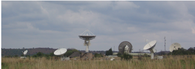
Fig. 6.4: CSIR:s center för satellittillämpningar i Hartbeeshoek nära Johannesburg. Särskilda antenner följer satelliterna när de passerar och laddar ner bilder med hjälp av radiovågor.
